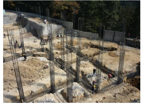
Fuente. Musi + Natarén Arquitectos.
