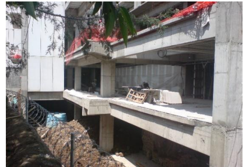
Fuente. Musi + Natarén Arquitectos.
