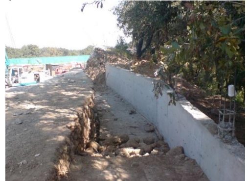
Fuente. Musi + Natarén Arquitectos.
