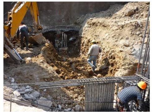
Fuente. Musi + Natarén Arquitectos.
