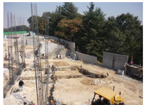
Fuente. Musi + Natarén Arquitectos.
