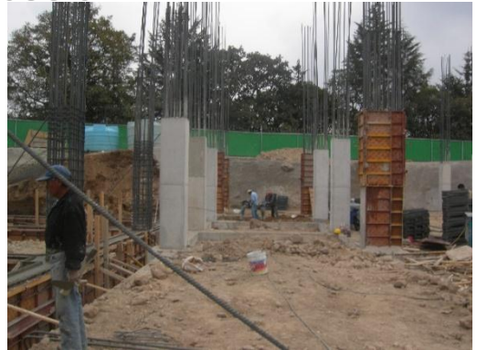
Fuente. Musi+ Natarén Arquitectos.
