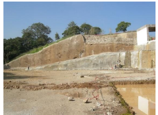
Fuente. Musi + Natarén Arquitectos.
