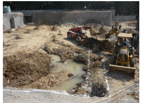
Fuente. Musi + Natarén Arquitectos.
