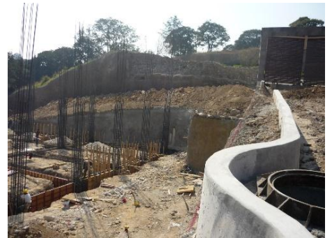
Fuente. Musi + Natarén Arquitectos.
