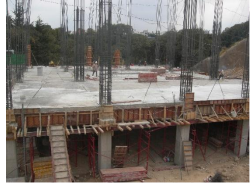
Fuente. Musi + Natarén Arquitectos.
