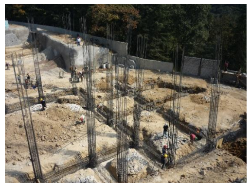
Fuente. Musi + Natarén Arquitectos
