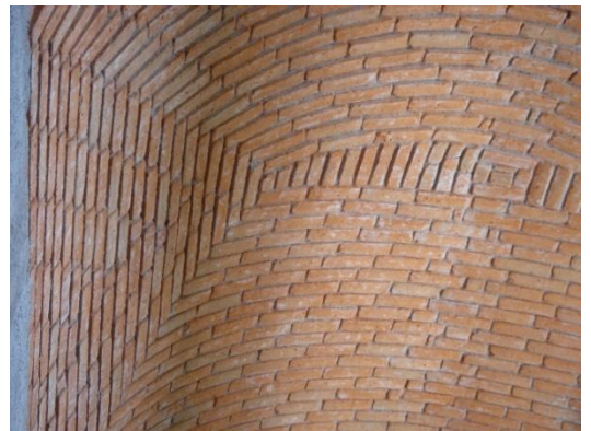
Fuente. Musi + Natarén Arquitectos
