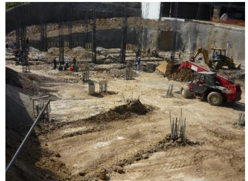
Fuente. Musi + Natarén Arquitectos.
