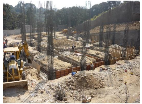
Fuente. Musi + Natarén Arquitectos.
