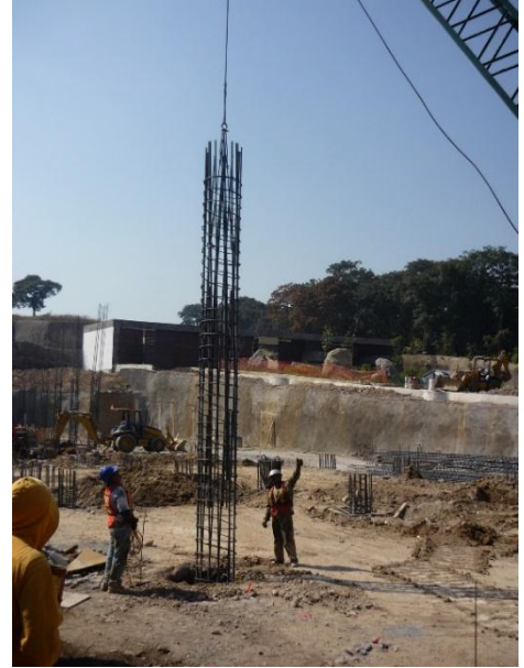
Fuente. Musi + Natarén Arquitectos.
