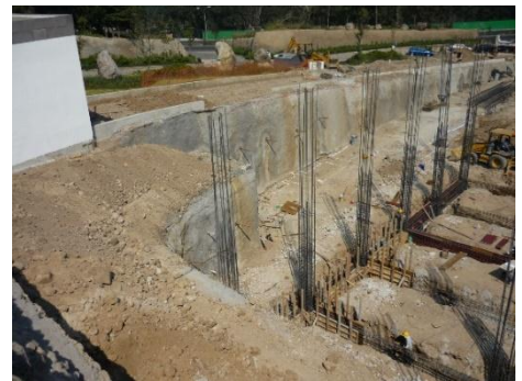
Fuente. Musi + Natarén Arquitectos.
